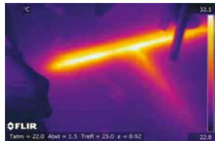
Dieses Wärmebild zeigt, wo die Warmwasserleitung im Boden verlegt wurde.
