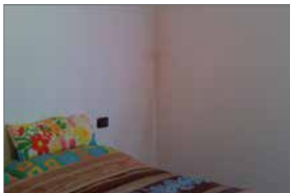
Der Temperaturunterschied zwischen dem kalten Bereich in der Ecke und der übrigen Mauer beträgt mehr als 5 °C.
