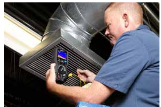
Typ-K-Thermoelement-Eingang zum Ausführen von Temperaturdifferenzmessungen
