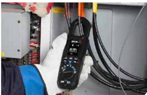
Überprüfung von Stromstärkemessungen
